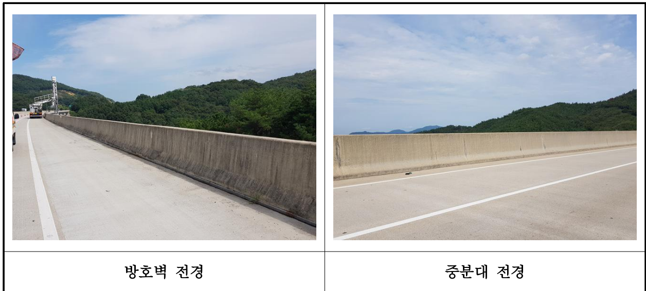
【사진 2.3.51】 방호벽 및 중앙분리대 전경
