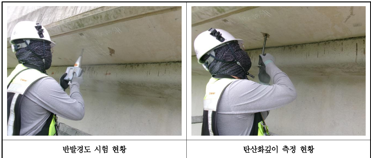
【사진 2.4.1】 콘크리트 내구성조사 현황
