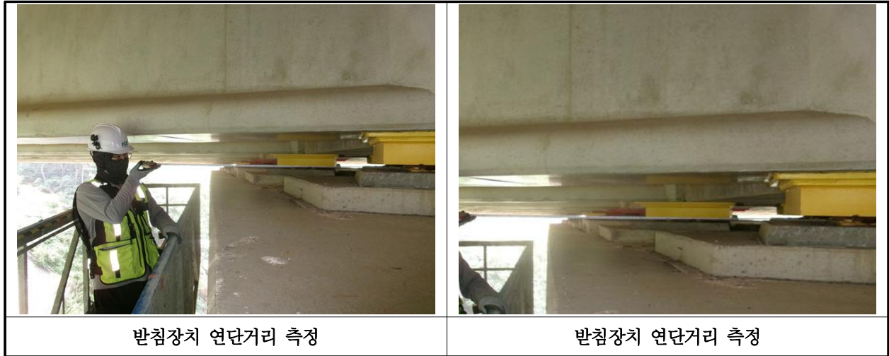
【사진 2.3.15】 교량받침장치 연단거리측정
