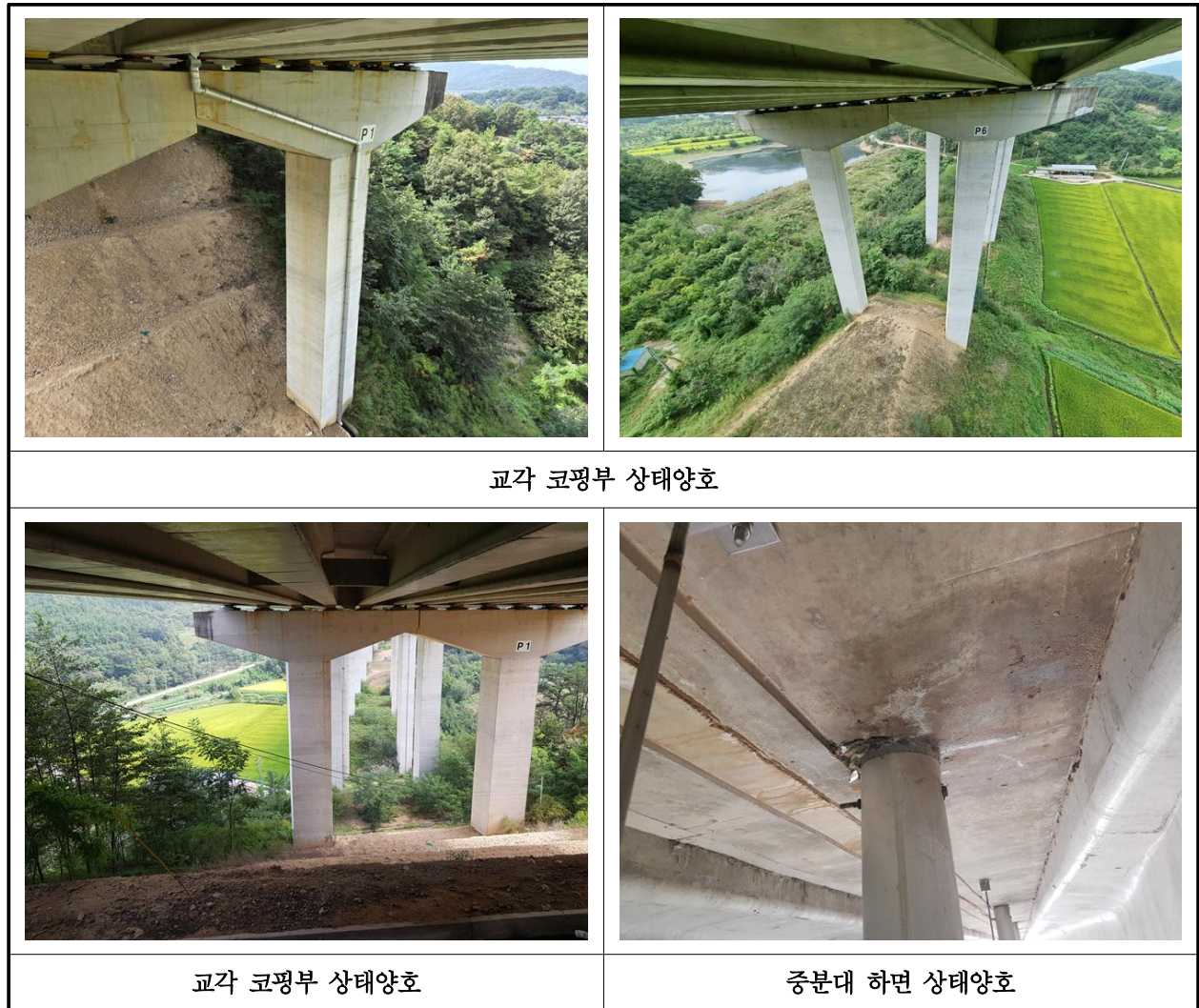
【사진 2.3.28】 교량의 공중이용시설 10대 위험요소 손상현황
