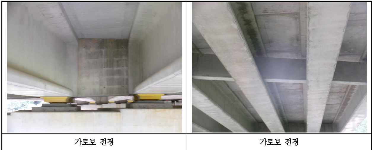
【사진 2.3.33】 가로보 전경
