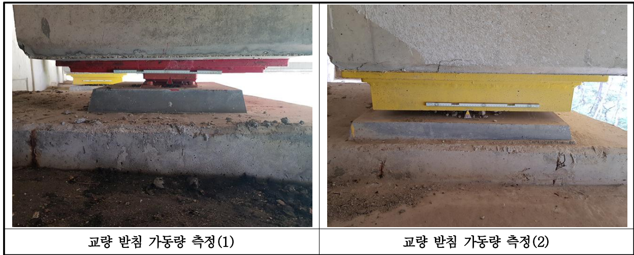
【사진 2.3.43】 교량받침 이동량 측정
