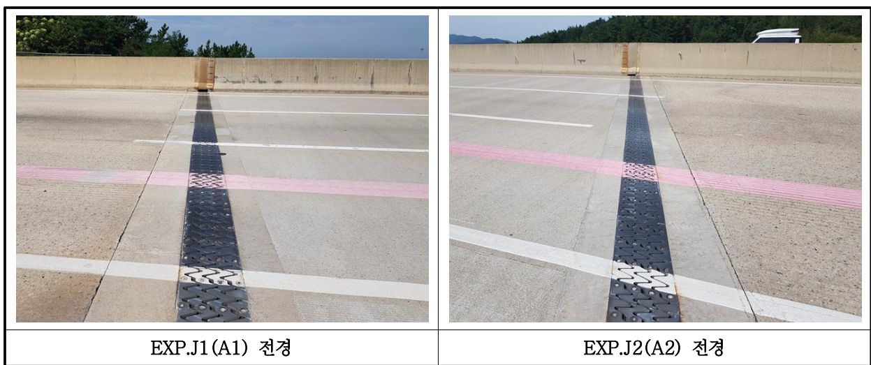
【사진 2.3.44】 신축이음장치 전경
