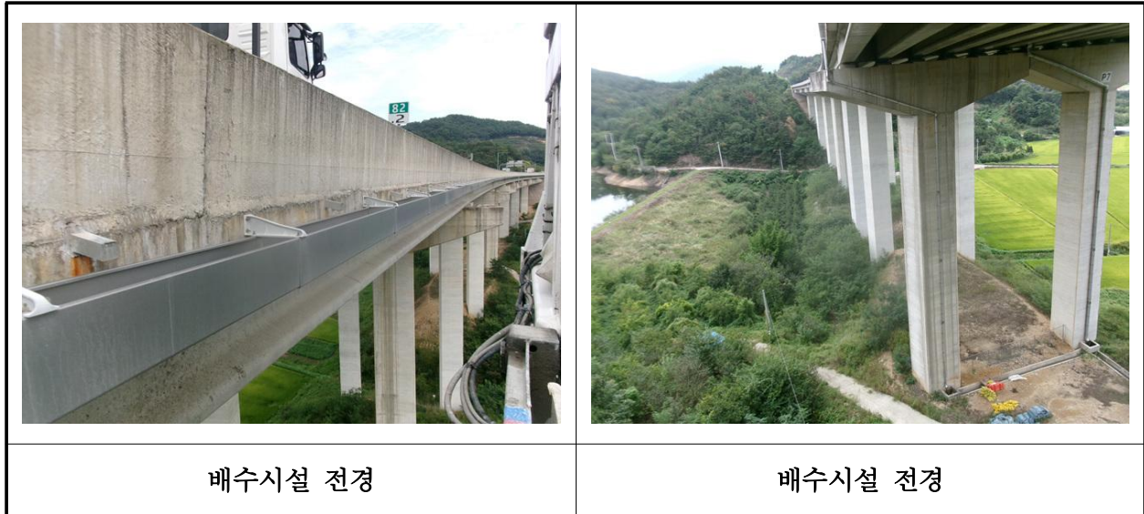
【사진 2.3.49】 배수시설 전경
