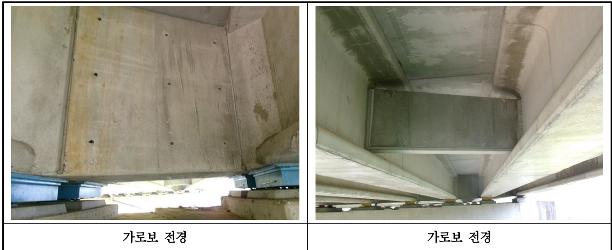
【사진 2.3.6】 가로보 전경
