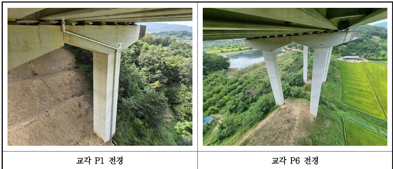
【사진 2.3.10】 교각 전경
