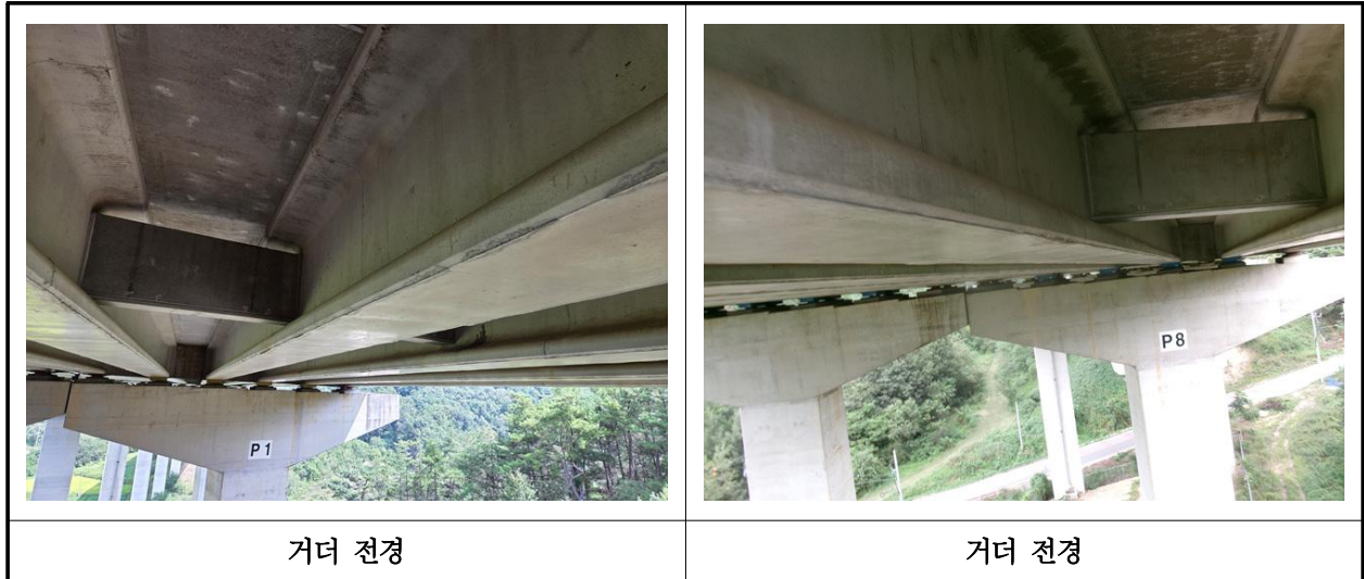
【사진 2.3.31】 거더 전경
