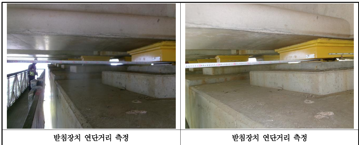
【사진 2.3.42】 교량받침장치 연단거리측정
