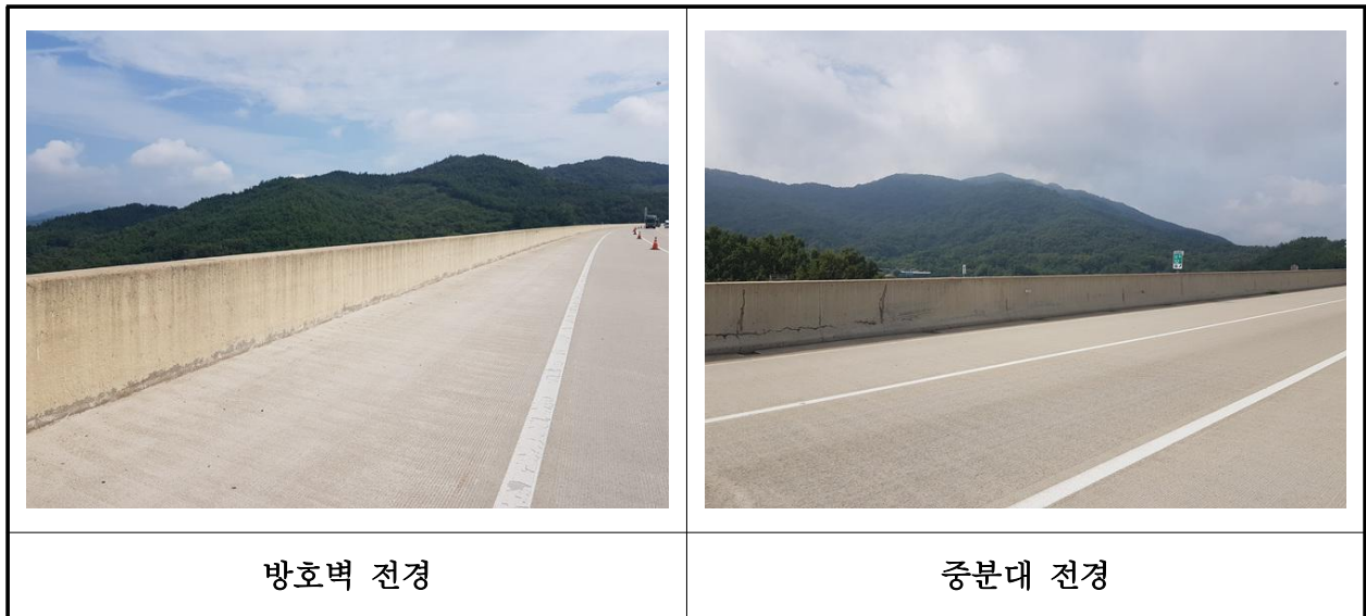
【사진 2.3.24】 방호벽 및 중앙분리대 전경
