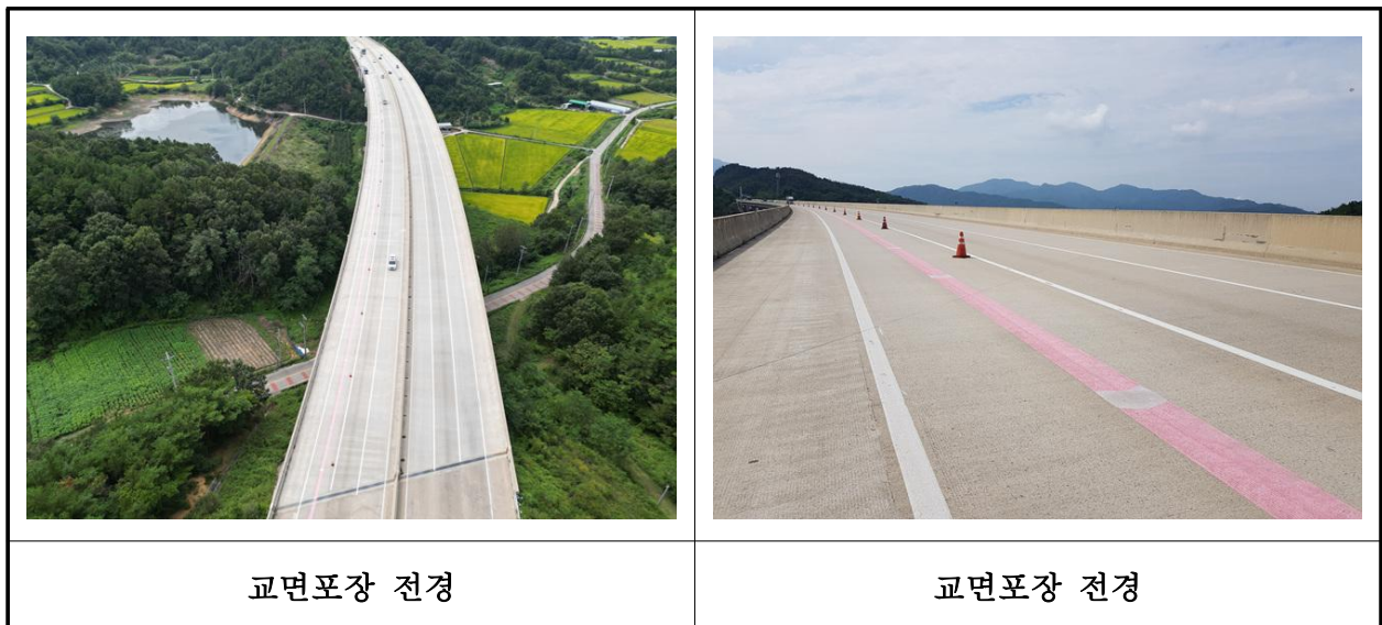
【사진 2.3.47】 교면포장 전경
