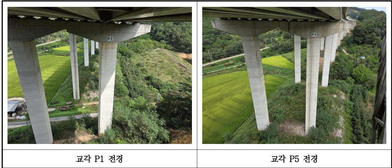
【사진 2.3.37】 교각 전경
