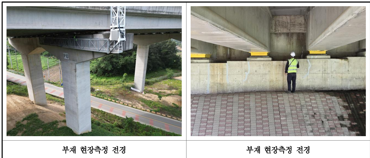
【사진 5.2.1】 부재 현장측정 전경
