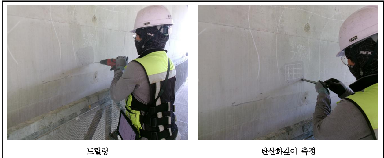
【사진 2.4.3】 탄산화 깊이 측정 현장사진
